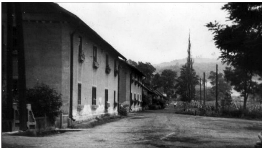
2. kép: Emeletes lakóház a temető felé. Ózd-Bánszállás, 1985
